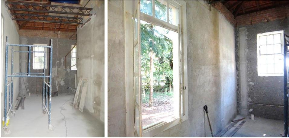
**Execução de contra piso para assentamento de piso porcelanato e preparação das paredes para instalação de revestimento cerâmico.**
