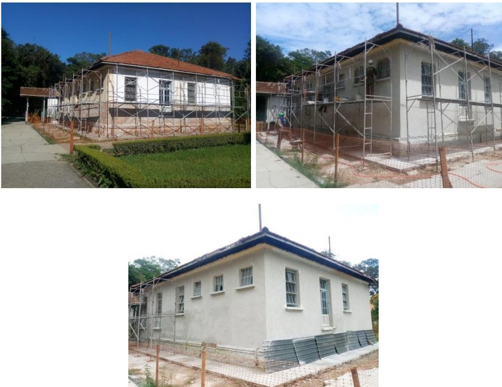
**Serviços de demolição do reboco danificado, tratamento da alvenaria e a aplicação de novo reboco.**
