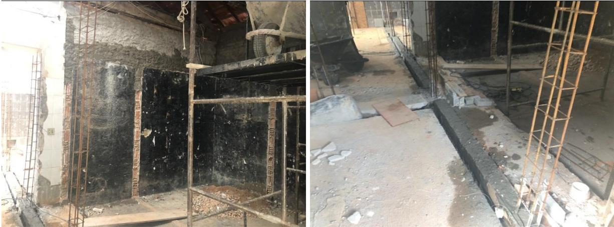
**Demolição de paredes internas para adequação do novo layout arquitetônico e execução de baldrame para nova alvenaria na área dos novos banheiros da edificação**
