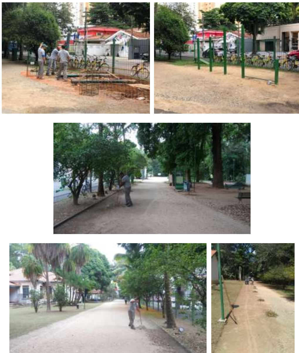
Instalação de barras de alongamento e manutenção da pista de caminhada.
