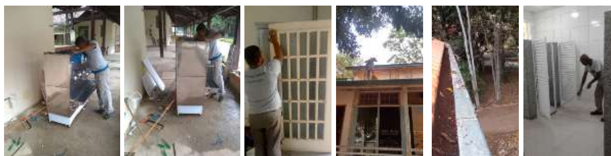
Atividades de manutenção e conservação.
