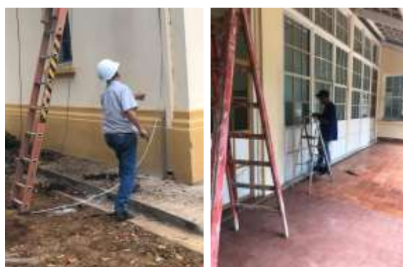
Instalação do SPDA e colocação de vidros nas esquadrias.
