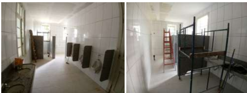
Obras de acabamento nos banheiros masculino e feminino do pavilhão Marina Crespi.
