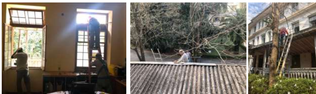
Serviços de manutenção e conservação das edificações.
